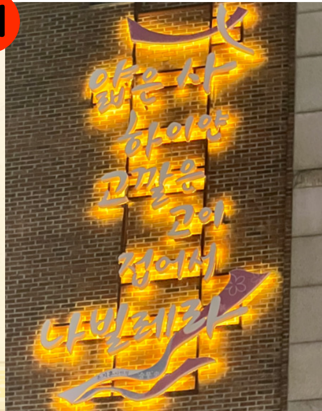
01 건물 사인조명 설치
